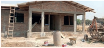
Le centre de santé de Damala en construction Bangui - République Centrafricaine
